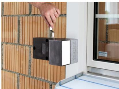
Regolare la posizione dell'staffa di montaggio TRA-WIK®-ALU-RL attraverso i piedini di regolazione in modo che sia a filo con la facciata. Campo di regolazione 5–15 mm.
