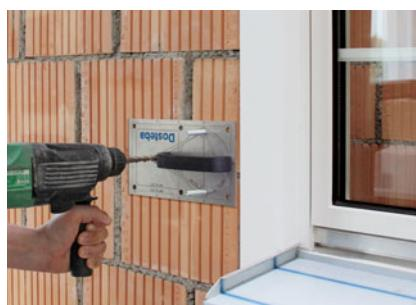
Bohrlöcher müssen gründlich vom Bohrstaub gereinigt werden.
