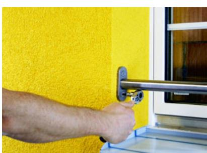
Für die Bestimmung der gesamten Verschraubungstiefe muss die genaue Dicke der Beschichtung auf dem Tragwinkel TRA-WIK®-ALU-RL bekannt sein. Die notwendige Schraubenlänge ergibt sich aus
