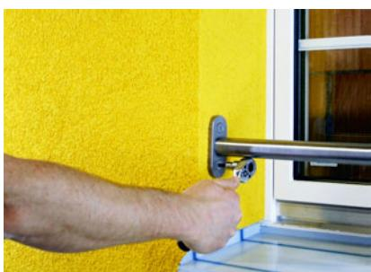
La lunghezza delle viti necessaria dipende dalla profondità dell'avvitamento, dallo spessore del rivestimento e dallo spessore del componente.
