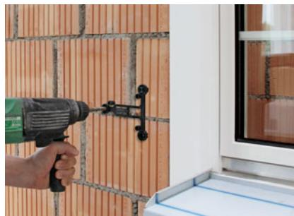
Mit Hilfe der Unterlage zweites Bohrloch bohren.
