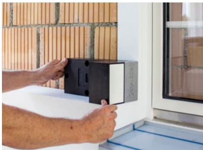
Tragwinkel TRA-WIK®-ALU-RL dämmplattenbündig anpressen.
