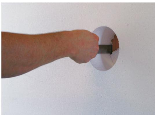
In caso di fresature in continuo grattare via i residui di spessore con un utensile adatto e ripulire la fresatura dalla polvere.
