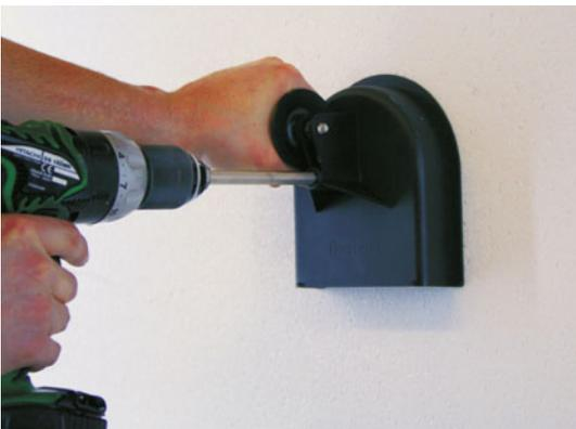
Fräsglocke fest an die Dämmplatte andrücken.
