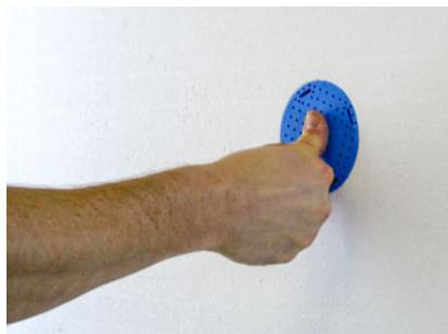
Premere la rondella di fissaggio DoRondo®-PE a filo dei pannelli isolanti nella sezione fresa.
