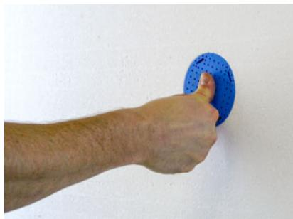
Montagerondelle DoRondo®-PE dämmplattbündig in die Ausfräzung pressen.
