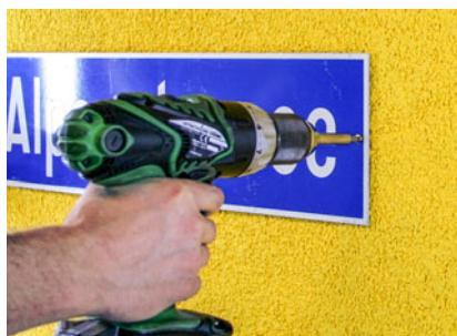
Anbauteile in der Montagerondelle DoRondo®-PE verschrauben.
