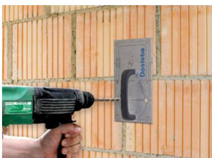
Bohrlöcher müssen gründlich vom Bohrstaub gereinigt werden.
