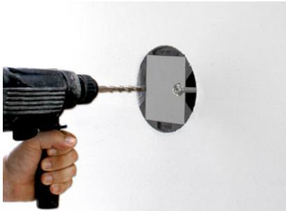
Eliminare lo spessore residuo utilizzando un utensile appropriato e, al termine dell'operazione, rimuovere tutta la polvere di fresatura accumulata.
