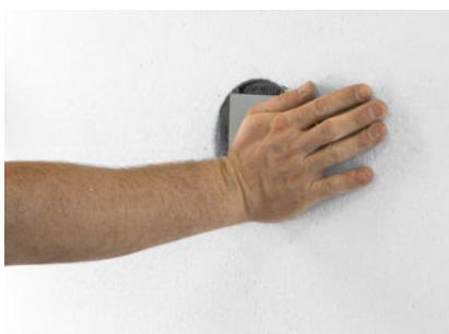
Universalmontageplatte UMP®-ALU-TZ dämmplattenbündig anpressen.
