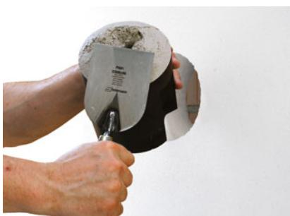
EPS-Formteile aus der Nische herausnehmen und auf die Klebefläche der Universalmontageplatte UMP®-ALU-TZ Klebemörtel aufziehen. Element muss vollflächig auf den tragfähigen Untergrund verklebt werden.
