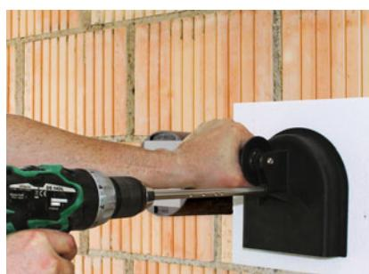
Fresatura con unità di fresatura per cilindro di montaggio su pannelli isolanti sciolti.
