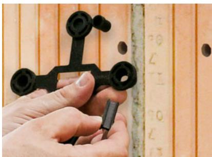
Mit Hilfe der Unterlage zweites Bohrloch bohren.
