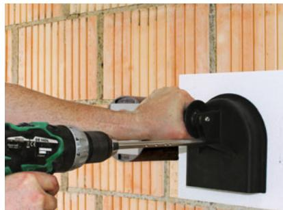
Mit Fräswerkzeug für Montagezylinder Ausfrässung in nicht verklebte Dämmplatte fräsen.
