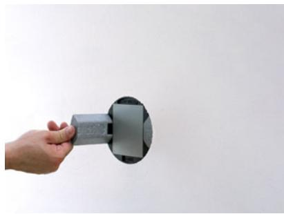
Spostare i pannelli isolanti fresati, quindi adattare i pannelli isolanti senza soluzione di continuità e inserire le fusioni in polistirolo espanso.
