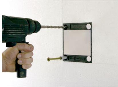
Non appena indurita la malta, inserire i perni di fissaggio e, premendo, inserire le formelle in EPS. Trapanare i muri con mattoni forati senza utilizzare la funzione percussione.
