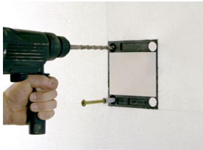
Nach dem Aushärten des Klebemörtels Schraubdübel versetzen und Formteile aus EPS einpressen. Mauerwerke mit Lochsteinen ohne Schlag bohren.
