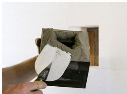
Appicare della malta adesiva sulla superficie d'incollaggio della piastra di montaggio universale UMP®-ALU-Q. L'elemento deve essere incollato coprendo la totalità della superficie sul fondo portante.
