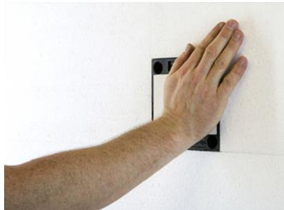
Universalmontageplatte UMP®-ALU-Q dämmplattenbündig anpressen.
