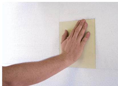
Applicare della malta adesiva sulla superficie d'incollaggio del blocco di montaggio Quadroline®-PU. L'elemento deve essere incollato coprendo la totalità della superficie sul fondo portante.
