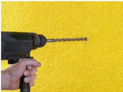
Dübelloch durch den Montagequader Quadroline®-PU bis ins Mauerwerk bohren.
