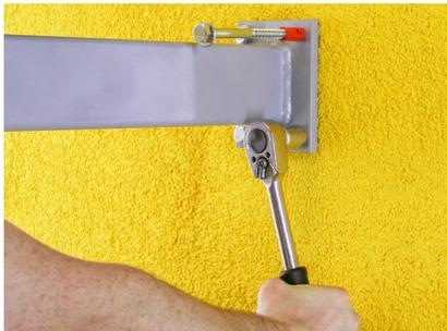
Anbauteil mit Schraubdübeln im Mauerwerk verankern.
